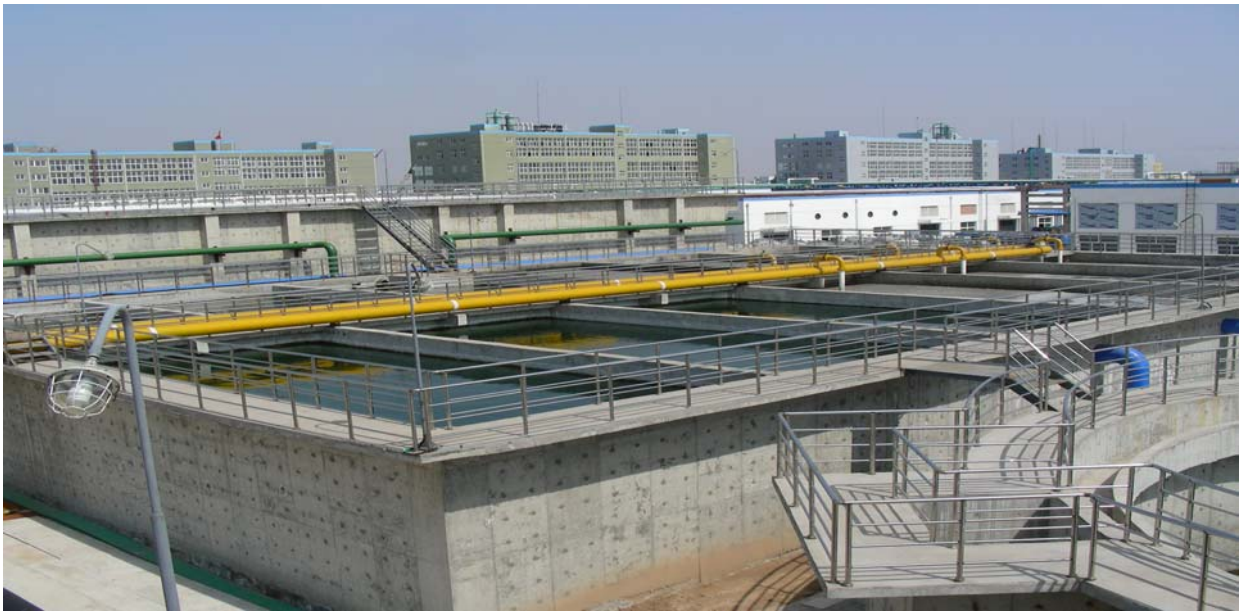
图 4.1-9 废水治理设施图片
